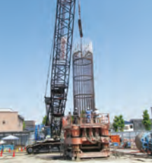
大口径建築基礎工事
