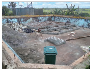
ソゲリ水プロジェクトの基礎工事現場 大型タンク基礎工事の写真
