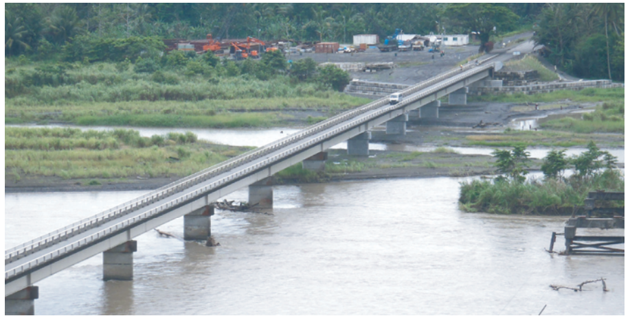
マーカム橋改修工事
