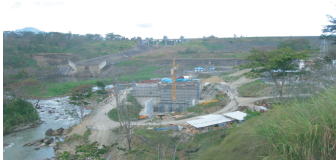
ヨンキ水力発電所 建設工事
